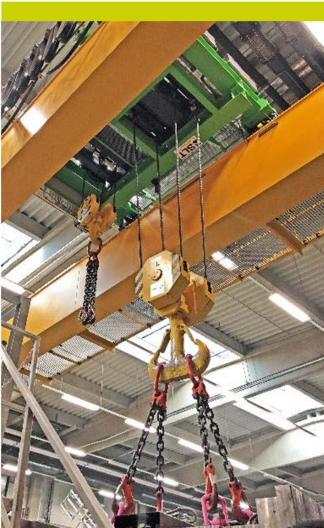
Auf dem vorhandenen Zweiträgerbrückenkrane wurde eine neue Laufkatze mit einem ASF 7 als Haupt- und einem SHF 6 als Hilfshub installiert.
